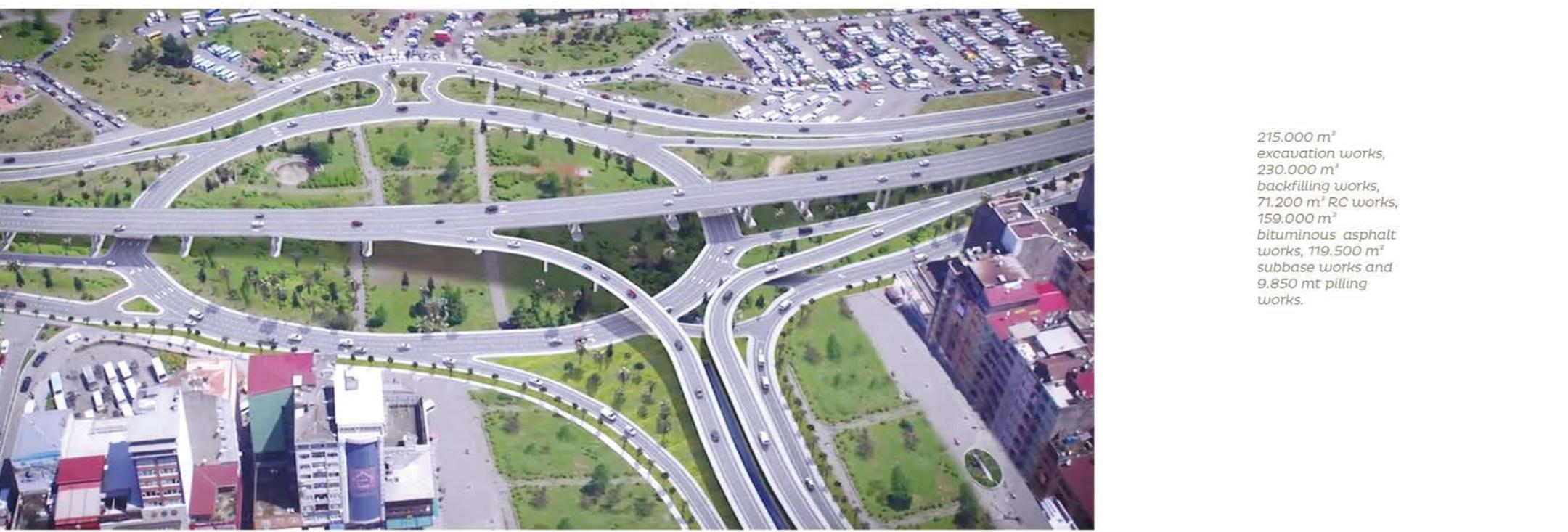
215.000 m<sup>3</sup> kazi, 230.000 m<sup>3</sup> dolgu, 71.200 m<sup>3</sup> betonarme imalatları, 159.000 m<sup>2</sup> bitümlü sıcak karışım asfalt yol, 119.500 ton plentmix ve 9.850 m fore kazık işleri.
